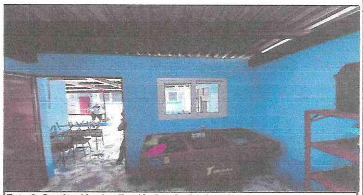
Foto 6: Sustitución de pila plástica de dos lavaderos
